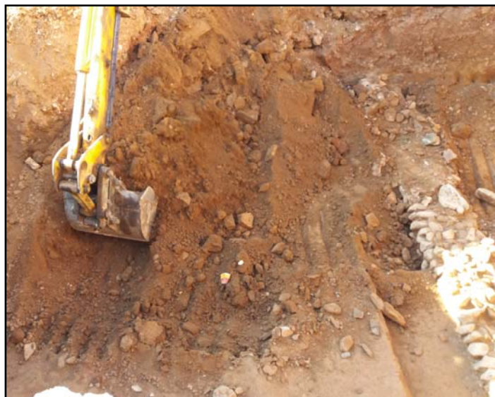
Fotografia 32. Desmuntatge UE 2012, des de l'est
