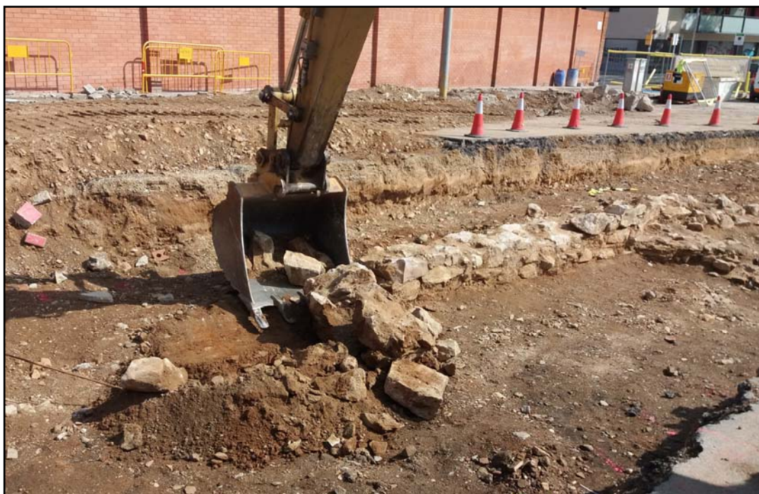
Fotografia 28. Desmuntatge del mur UE 1033, des del sud
