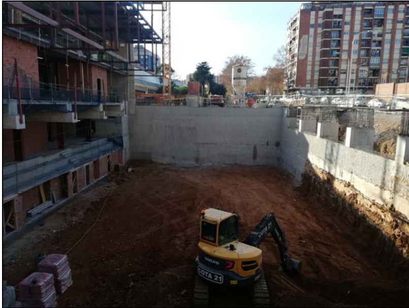
Fotografia 38. Vista general dels rebaixos de la zona de la rampa.
