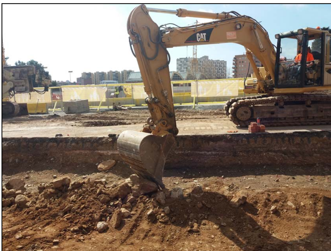
Fotografia 29. Desmuntatge del mur UE 1033, des del nord
